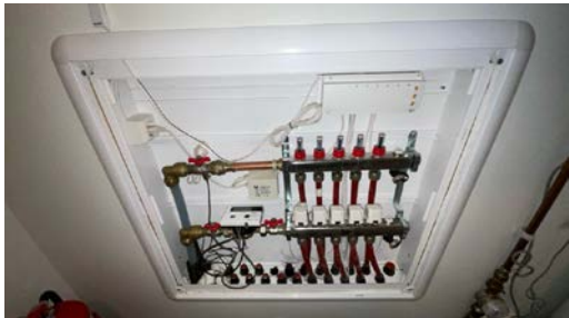
Fordelerskap gulvvarme
