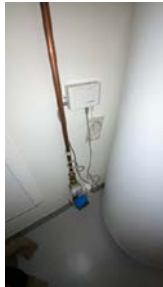
Hovedstoppekrane med vannstopventil og vannmåler
