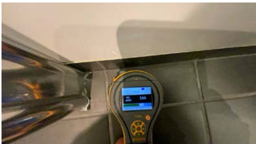
Fuktsøk er utført på gulv ved dusjdør. Ingen forhøyde fuktavvik er målt
