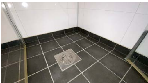
Soddellist er montert på veggplater i overgang flis og vegg.
