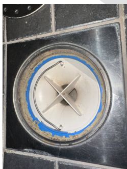
Plastsluk med klemring for membran
