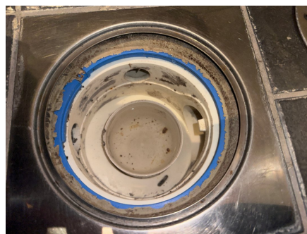
Plastsluk med klemring for membran
