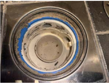
Plastsluk med klemring for membran
