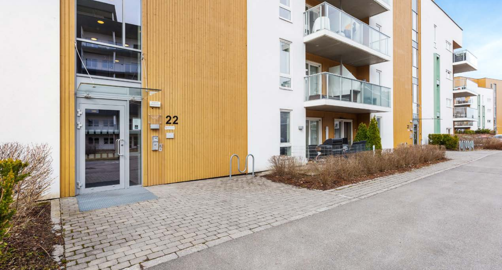
Inngangsparti til bygget.
