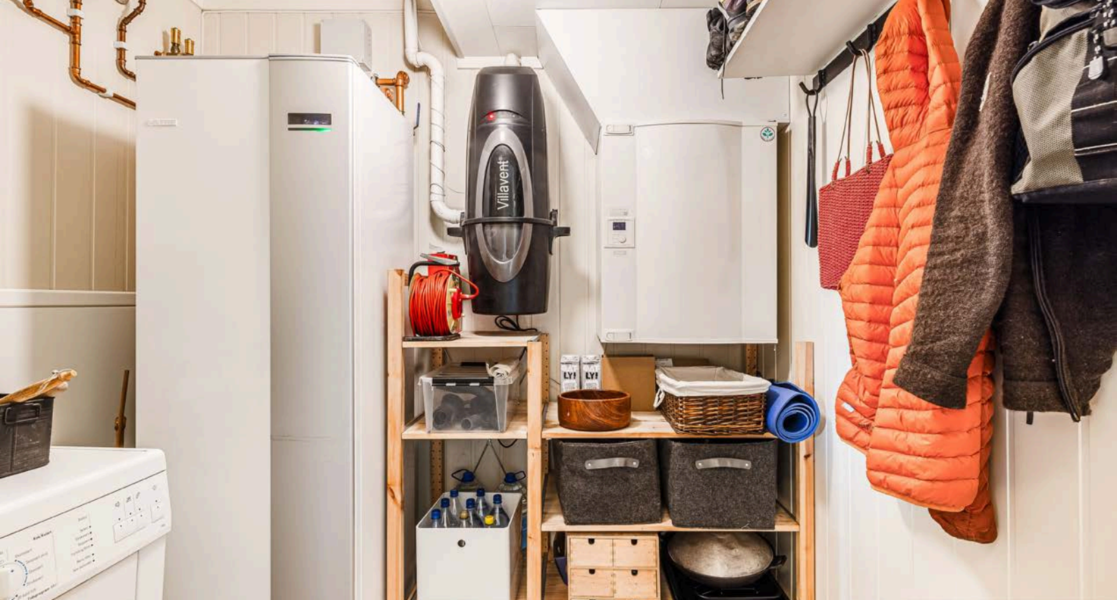
Fra entréen har du adgang til et praktisk bod/teknisk rom oppbevaringsplass.
