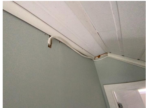
Noe kabler som ikke er helt fagmessig utført.
