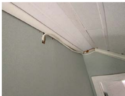
Noe kabler som ikke er helt fagmessig utført.
