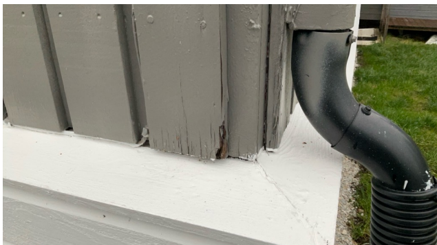
Råteskader i kledningen.
