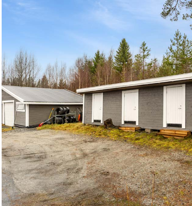
Høstbilder fra Einerhaugveien 24.
