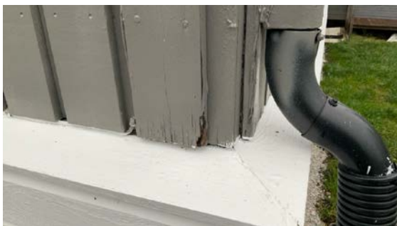
Råteskader i kledningen.
