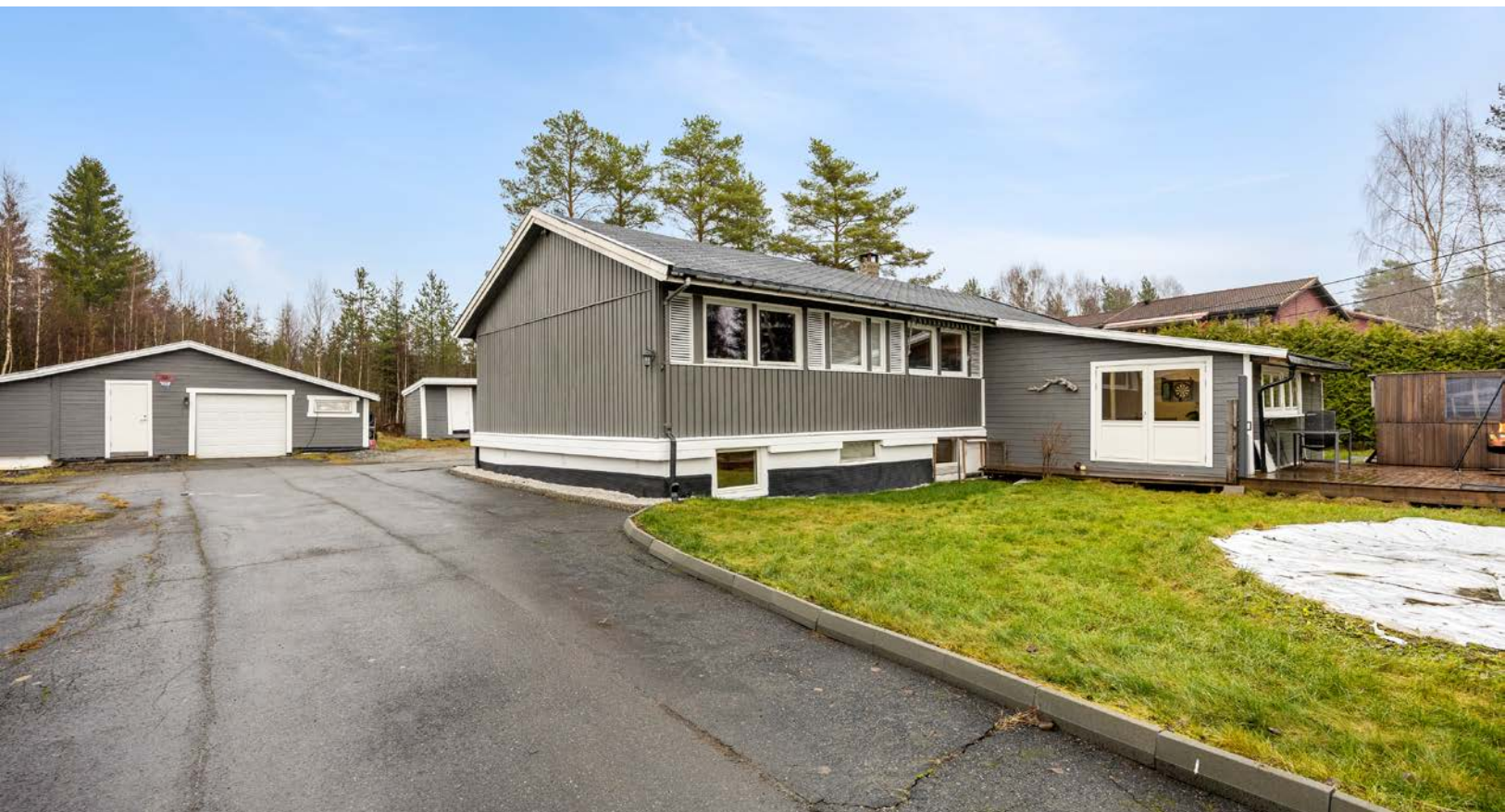
Høstbilder fra Einerhaugveien 24.
