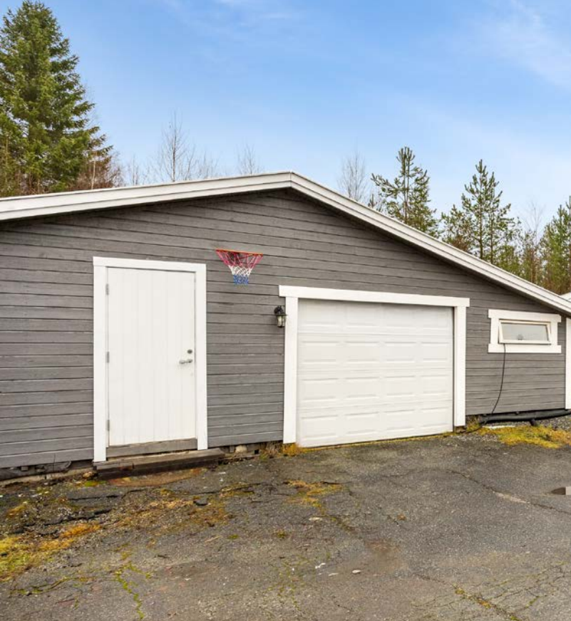
Høstbilder fra Einerhaugveien 24.
