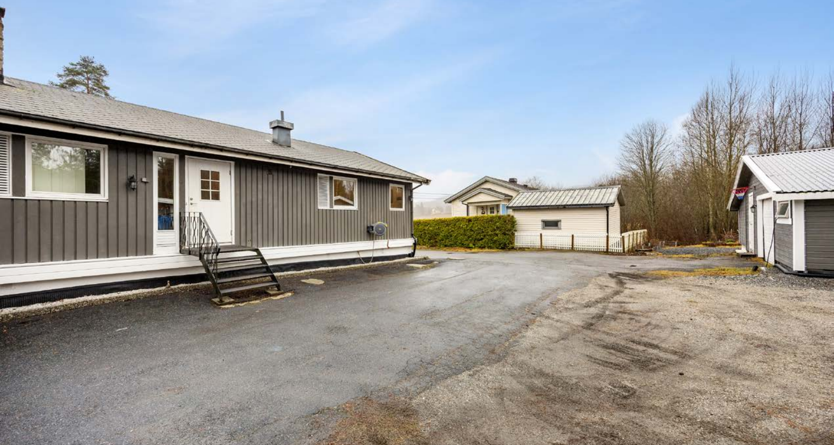
Høstbilder fra Einerhaugveien 24.
