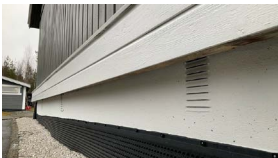
Råteskader i kledningen.
