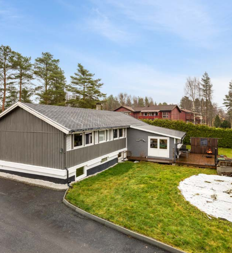
Høstbilder fra Einerhaugveien 24.
