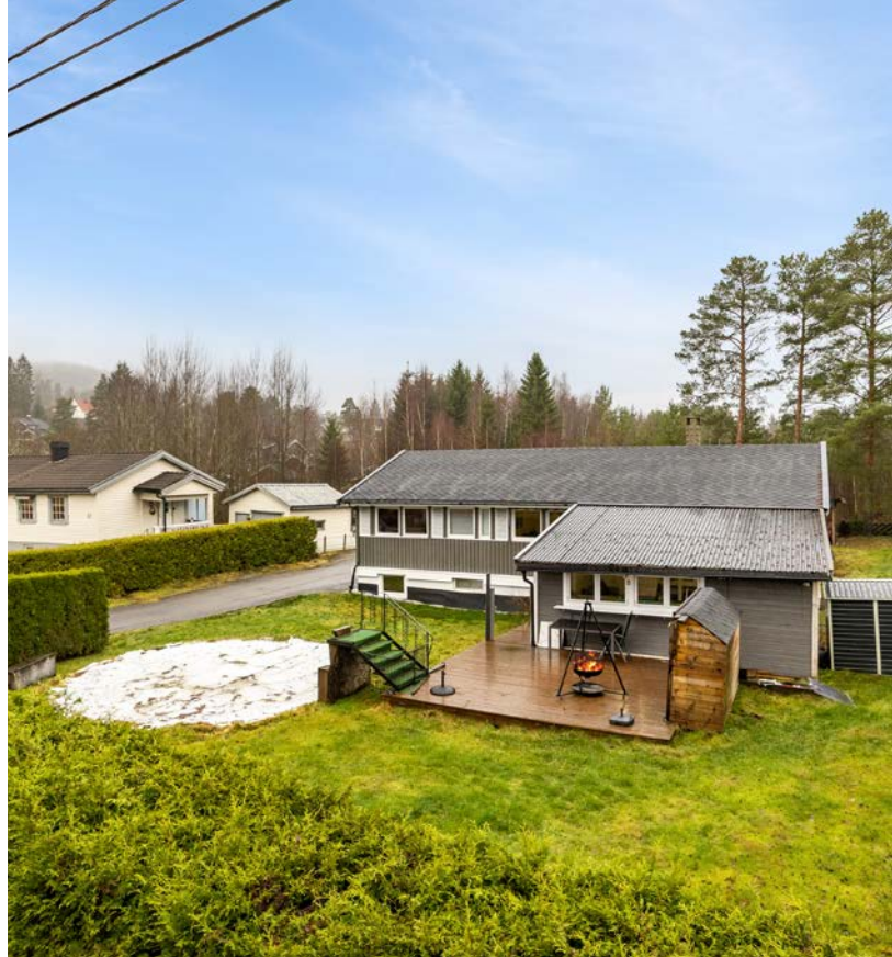
Høstbilder fra Einerhaugveien 24.
