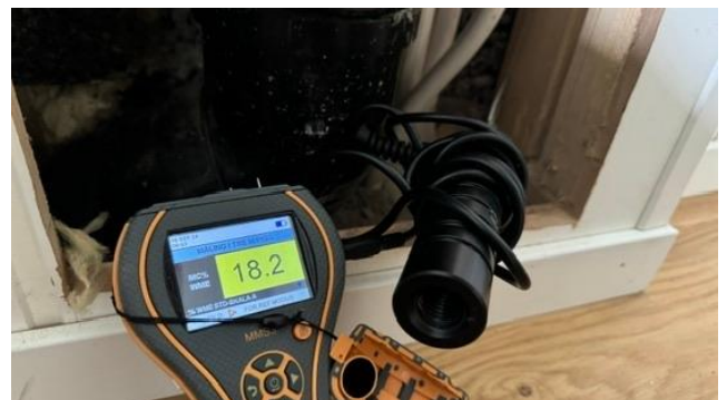
Bilde viser måling med pigg i inspeksjonsluke i rom mot terreng.
