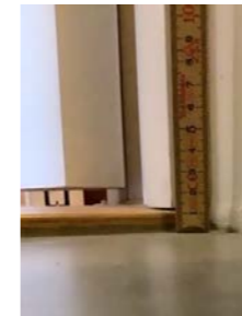
Dagens krav krever oppkant av membran på min 15 mm ved terskel.
