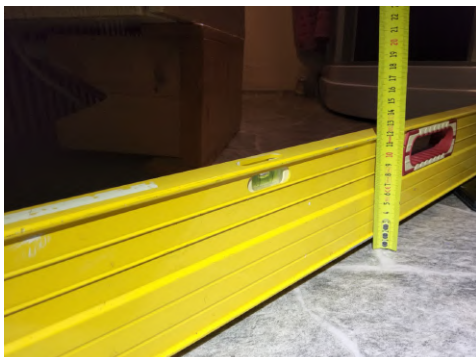
Bildet viser måling av fall på gulv.
