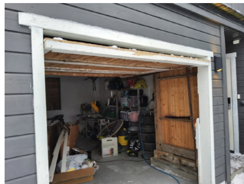
Ytterdør til utleiedel mangler beslag
