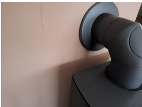
Sotluke for nært brennbart materiale.
