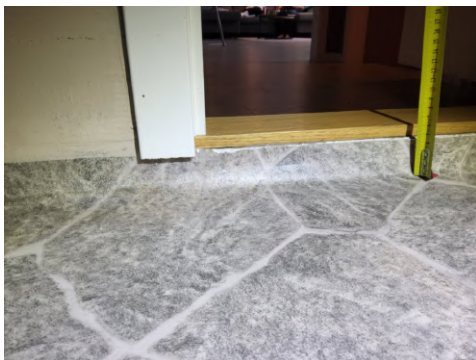
Bildet viser måling av fall på gulv.
