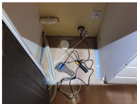
Fuktmåling fra kjøkken. Ingen fukt.
