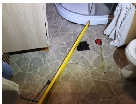
Bildet viser måling av fall på gulv.
