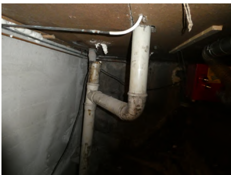
Avløpsrør i krypekjeller
