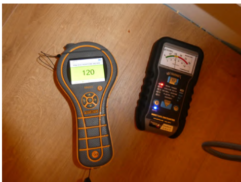
Fuktmåling på kjøkkengulv
