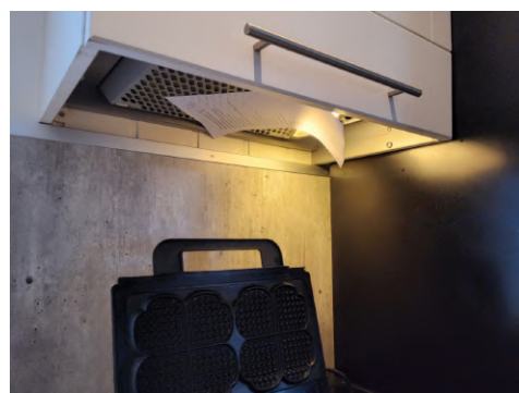
Avtrekk testet med papirark. Fungerer bra
