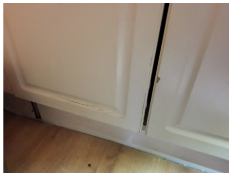
Fuktskadete skapdører
