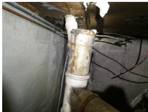
Avløpsrør i krypekjeller
