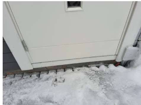
Ytterdør til utleiedel mangler beslag
