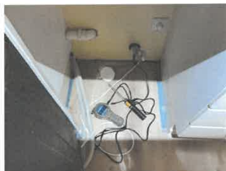
Fuktmåling fra kjøkken. Ingen fukt.
