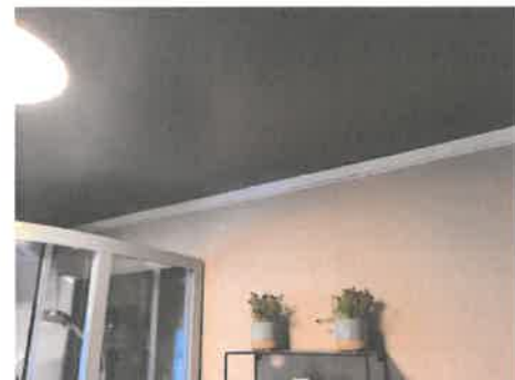
Vegger og tak. ETASJE > BAD
