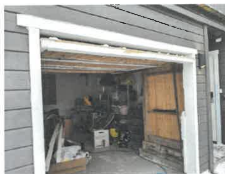
Ytterdør til utleiedel mangler beslag
