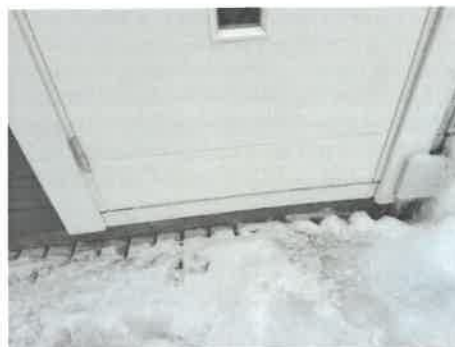
Ytterdør til utleiedel mangler beslag
