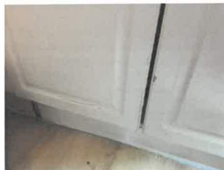
Fuktskadete skapdører KJELLER > KJØKKEN
