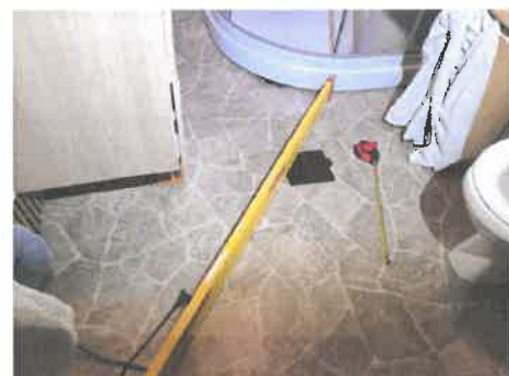
Bildet viser måling av fall på gulv.
