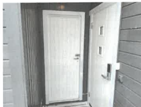
Dør til garasje og dør til hus til høyre
