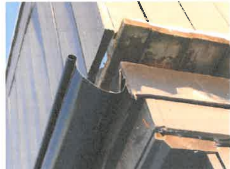
Tekking og beslag fra siden
