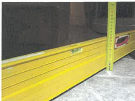
Bildet viser måling av fall på gulv.
