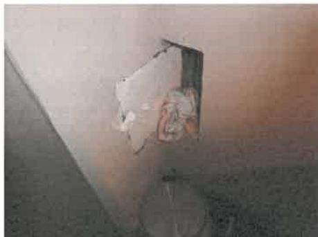
Sotluke for nært brennbart materiale.
