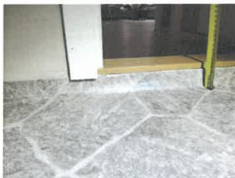
Bildet viser måling av fall på gulv.
