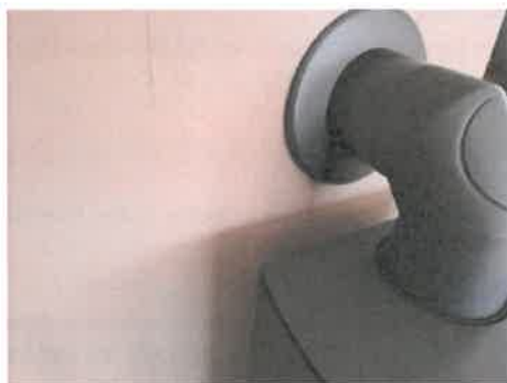
Sotluke for nært brennbart materiale.
