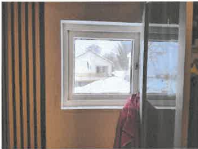
Vindu nært dusj.
