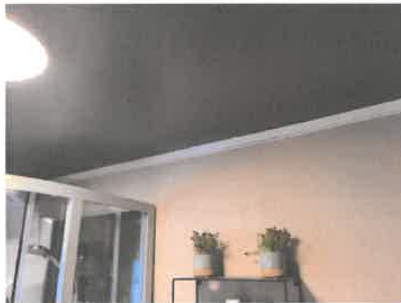
Vegger og tak. ETASJE > BAD
