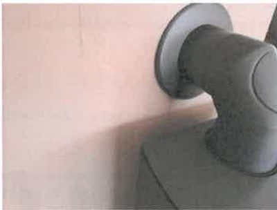
Sotluke for nært brennbart materiale.
