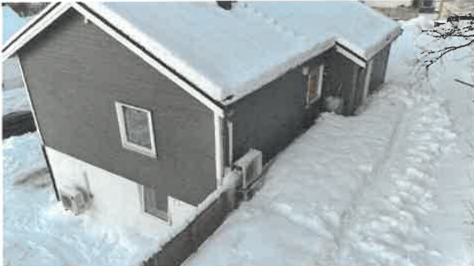
Dronebilde av snødekket ta. Ikke mulig å inspisere taktekking.
