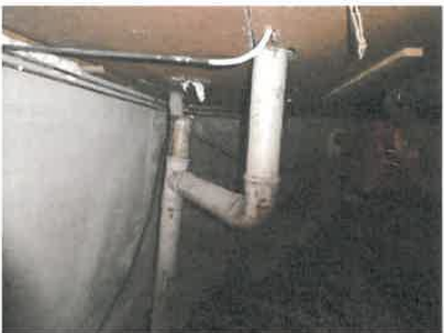
Avløpsrør i krypekjeller
