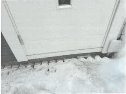
Ytterdør til utleiedel mangler beslag
