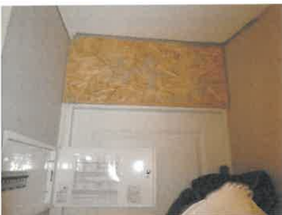
OSB plate med uferdig overflate
