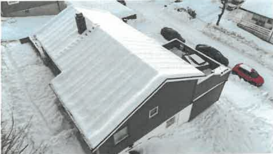
Dronebilde av snødekket ta. Ikke mulig å inspisere taktekking.
