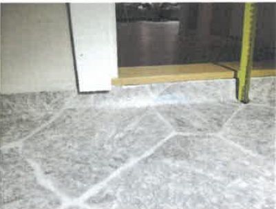
Bildet viser måling av fall på gulv.
