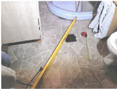
Bildet viser måling av fall på gulv.
