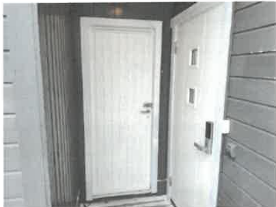
Dør til garasje og dør til hus til høyre
