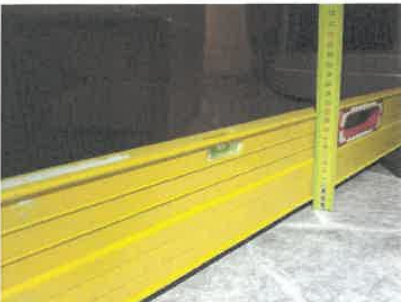
Bildet viser måling av fall på gulv.
