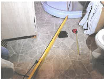
Bildet viser måling av fall på gulv.
