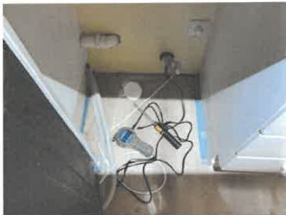
Fuktmåling fra kjøkken. Ingen fukt.
