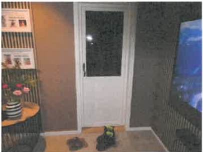
Innvendig balkongdør 1 etg.
