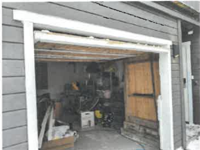
Ytterdør til utleiedel mangler beslag
