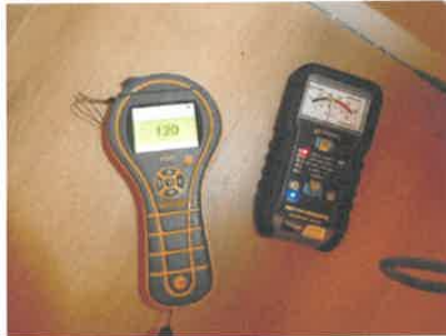
Fuktmåling på kjøkkengulv
