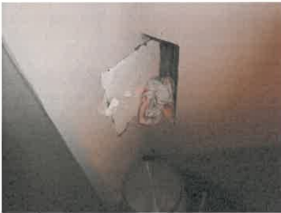
Sotluke for nært brennbart materiale.
