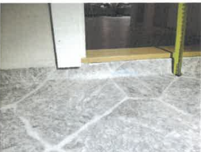
Bildet viser måling av fall på gulv.
