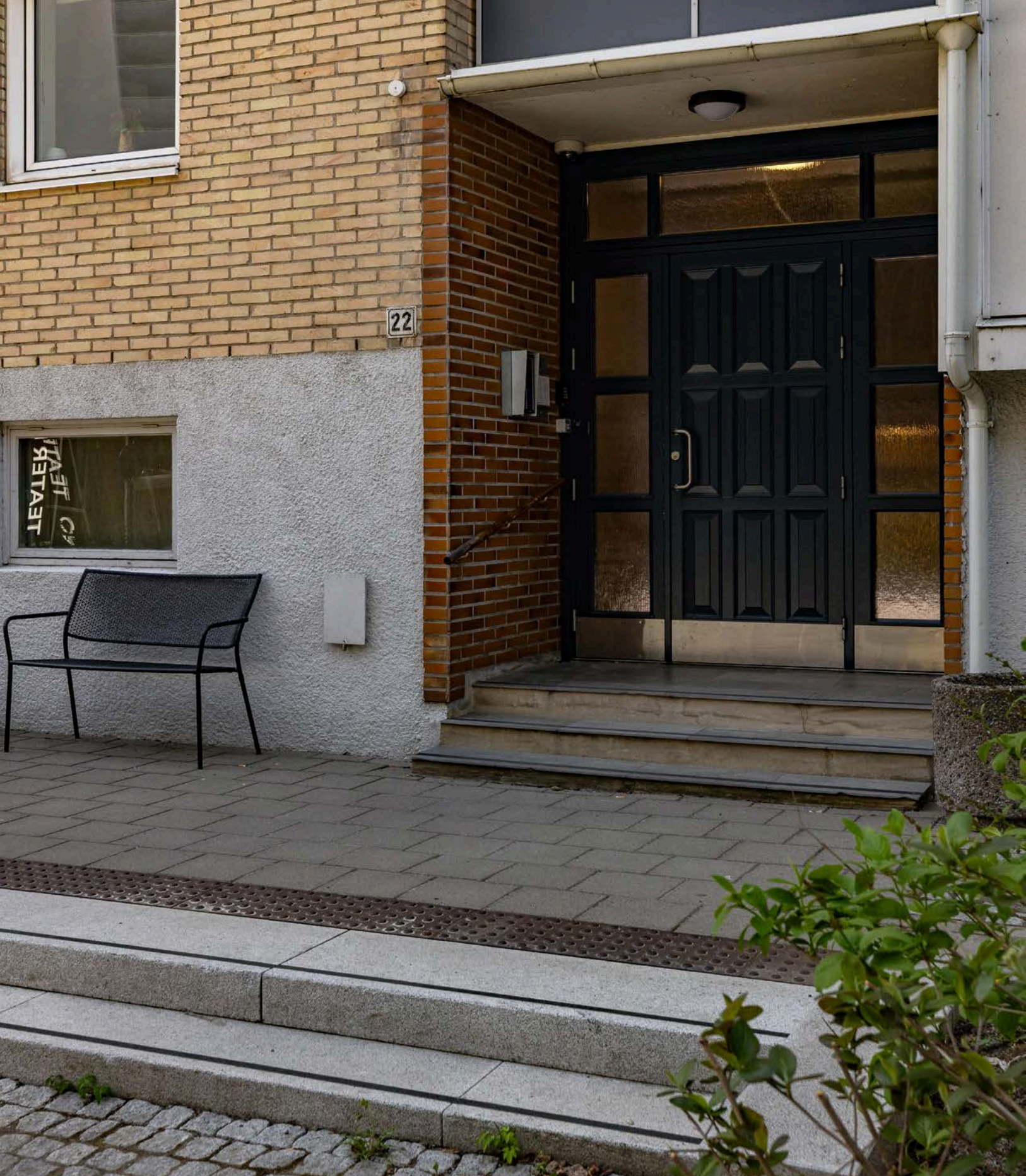
Overbygget inngangsparti med ytterdør fra 2018 og porttelefonlegg fra 2016.
