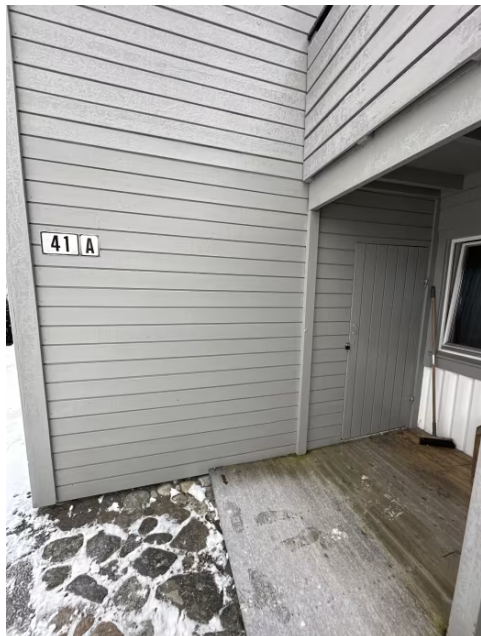
Viser bod med utvendig adkomst.
