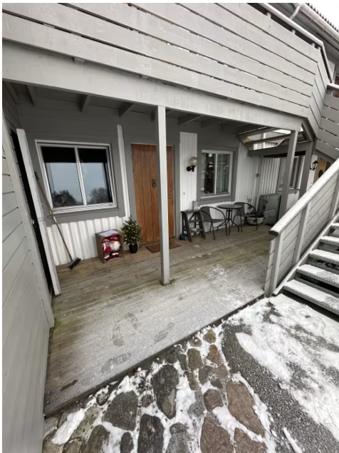
Viser delvis overbygget terrasse ved inngangsparti.
