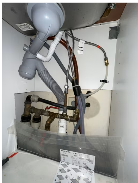
Viser vann og avløpsinstallasjoner under kum.
