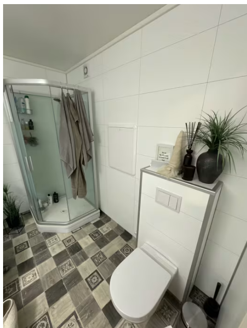
Viser toalett med innebygget sisterne og dusjkabinett.
