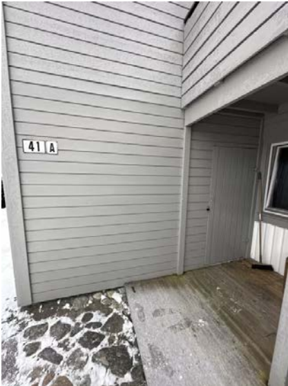
Viser bod med utvendig adkomst.
