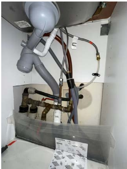
Viser vann og avløpsinstallasjoner under kum.
