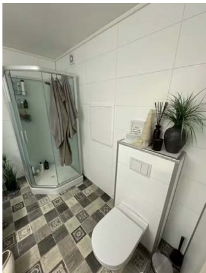
Viser toalett med innebygget sisterner og dusjkabinett.
