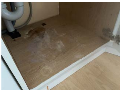
Fuktmerker og skader på skrog skap under vask.
