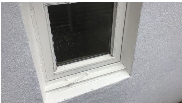
Vindu i mur
