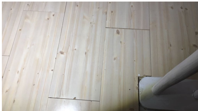
Utette skjøter i laminatgulv på loft
