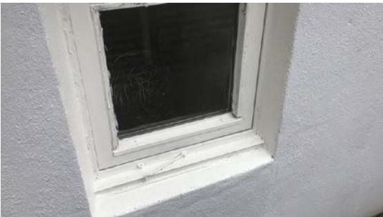
Vindu i mur
