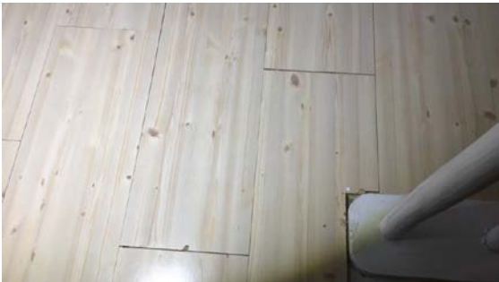
Utette skjøter i laminatgulv på loft
