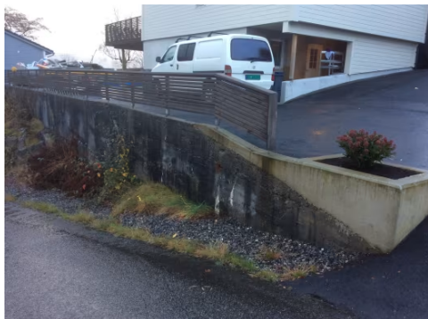
Mur mot gate.
