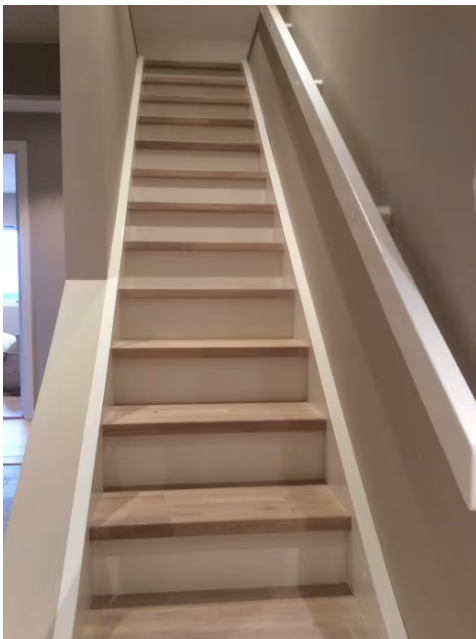
Ny trapp til 2. etasje.
