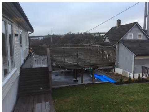
Nybygget terrasse utenfor stue.
