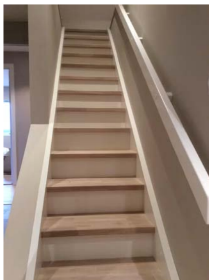
Ny trapp til 2. etasje.
