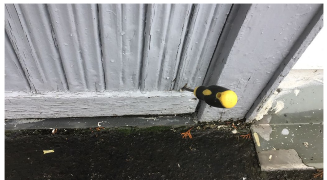
Balkongdør på soverom 1 etg
