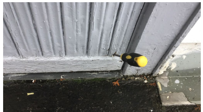
Balkongdør på soverom 1 etg
