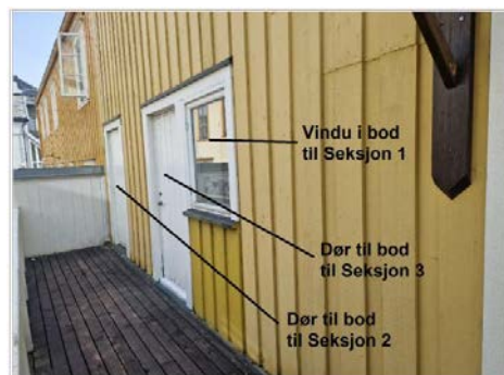
Bilde nr. 1.2.: Dører og vindu til tre boder
