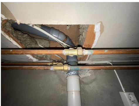
Vannmåler og stoppekran i kjeller.
