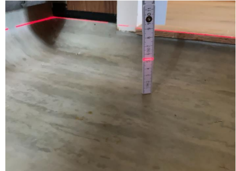
Høyde gulv ved dør
