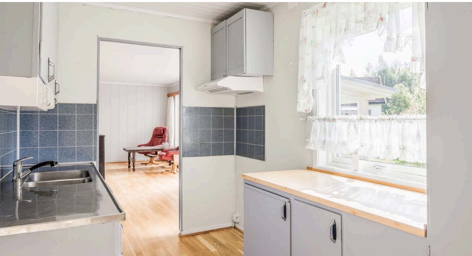
Skapmontert kjøkkenventilator med avtrekk ut og plass til frittstående komfyr under.
