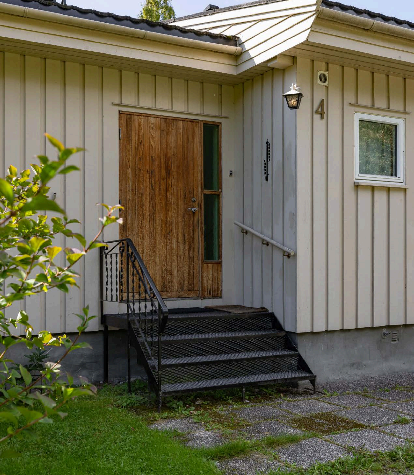
Boligen ble oppgradert i 2012 med nytt tak, flere nye vinduer samt nytt gulv i stue og kjøkken.
