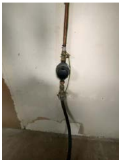
Vannmåler og stoppekran i kjeller.
