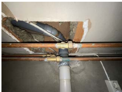
Vannmåler og stoppekran i kjeller.
