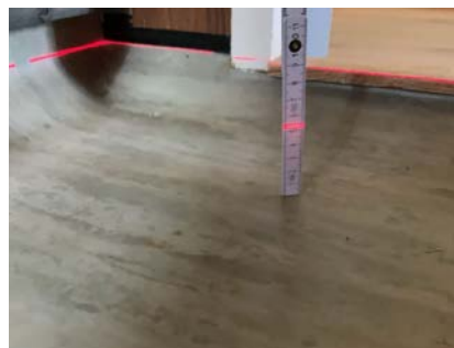
Høyde gulv ved dør
