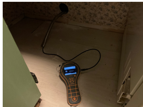
Hulltaking i kjøkkenvegg mot dusjkabinett 27.02.2022
