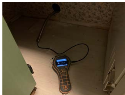
Hulltaking i kjøkkenvegg mot dusjkabinett 27.02.202
