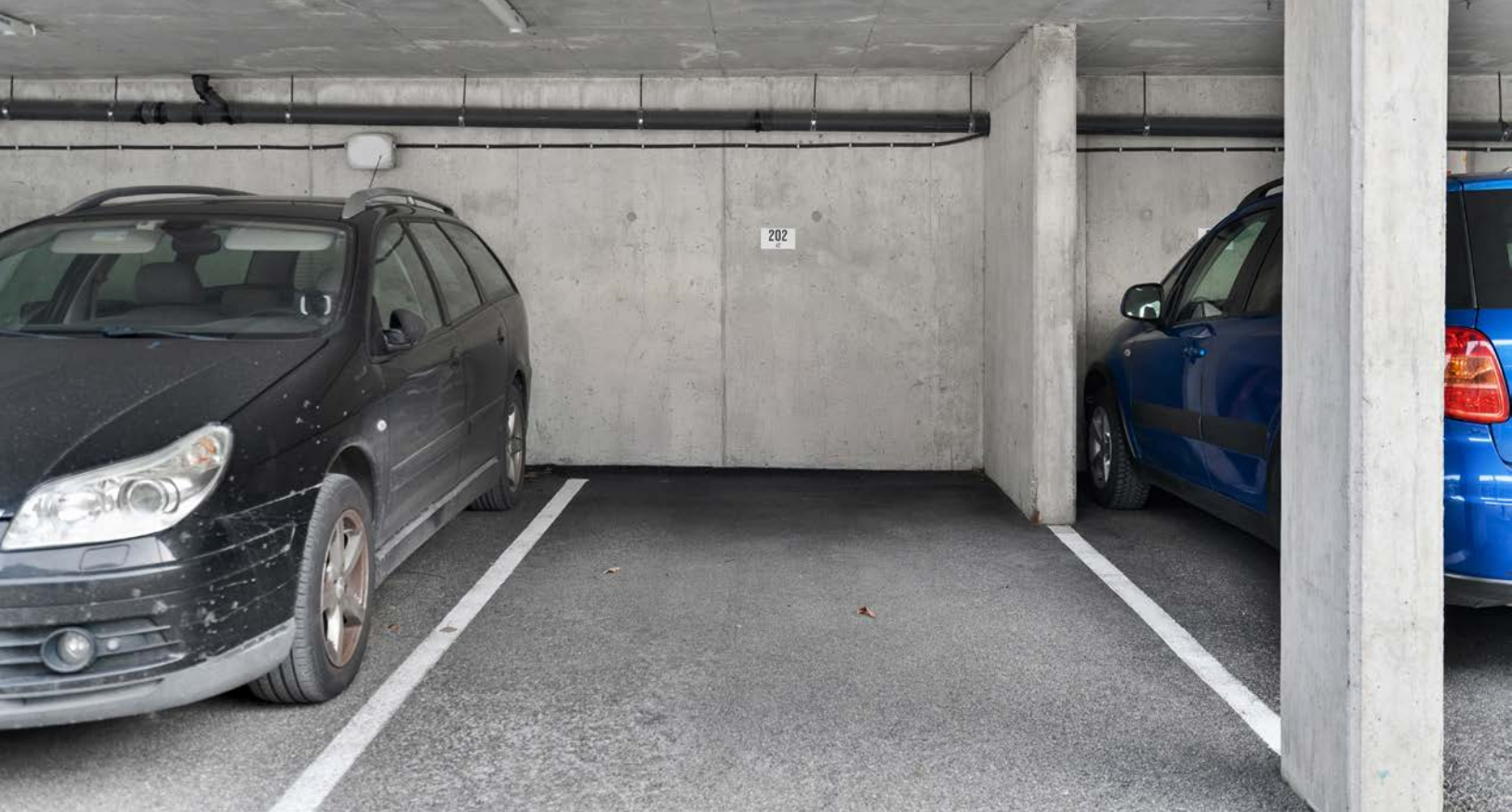
Fast parkering under tak. Mulighet for el-lader.
