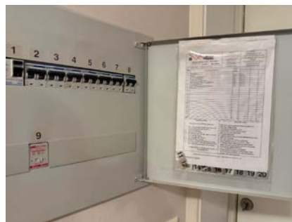
Sikringsskap i gang med automatisk sikringer
