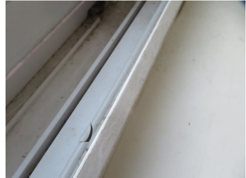
Skadet pakning.
