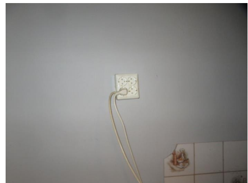
Løs kabel til stikkontakt i bod.
