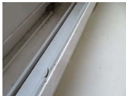
Skadet pakning.
