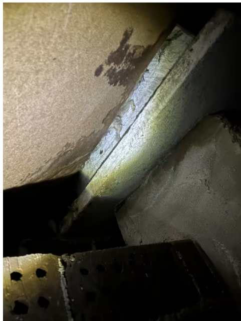
Pipe på loft.
