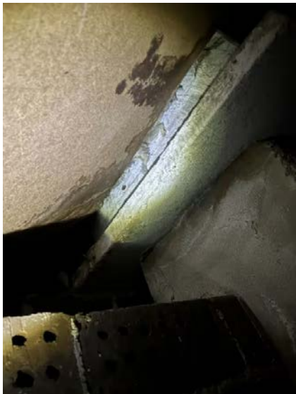
Pipe på loft.
