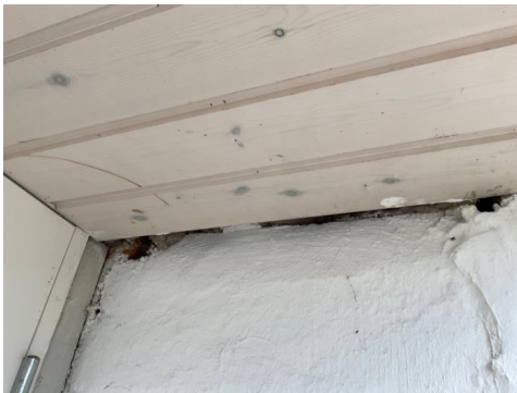
Utettheter i tak i fbm. inngangsparti til leilighet.
