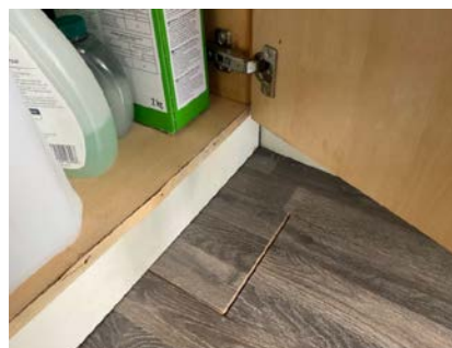
Svelling på bunnplate i benkeskap.
