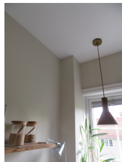
Innkassing av ventilasjons-rør fra kjeller og opp til ventilasjons-anlegg på loft.
