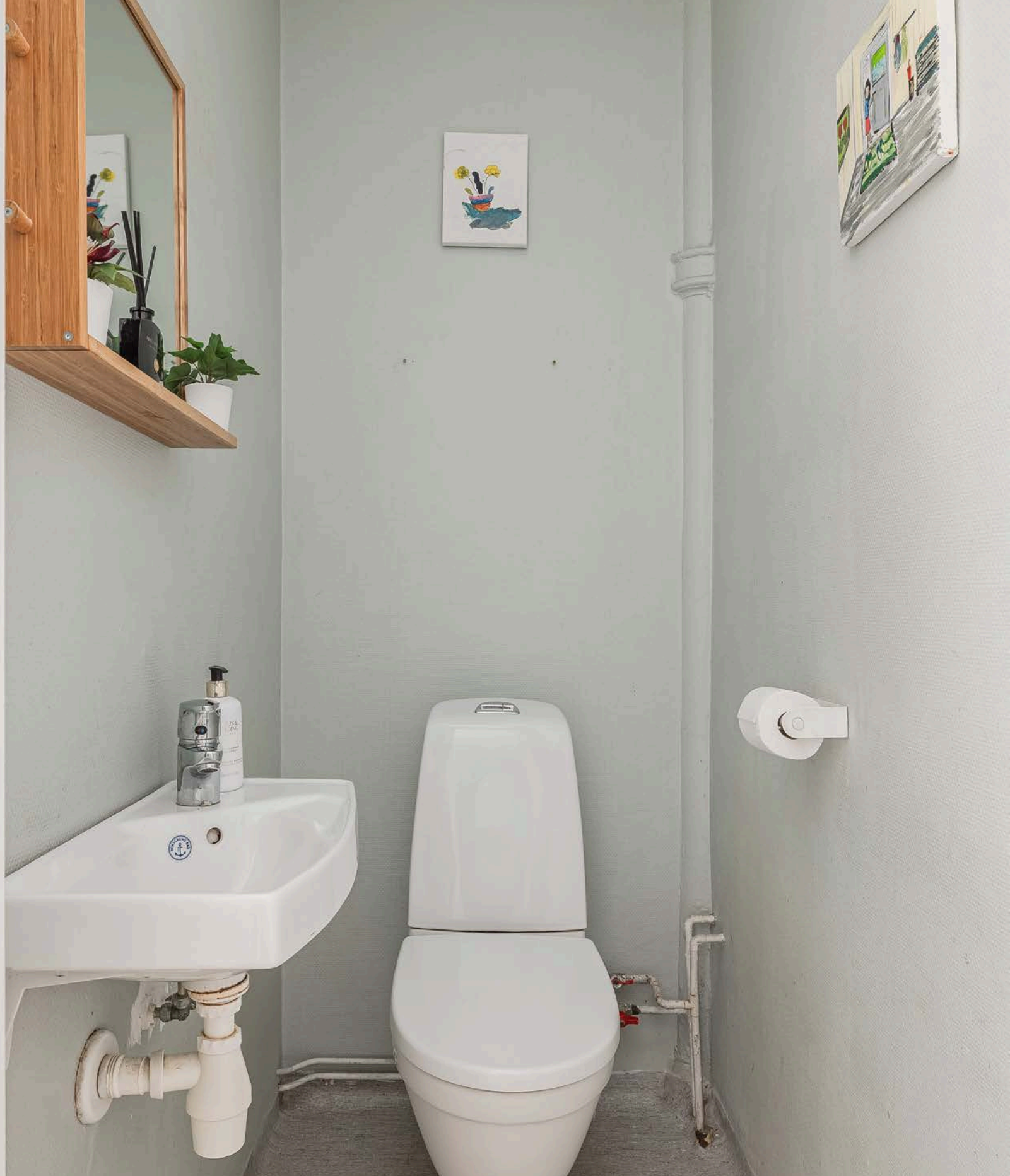
Vegg-i-vegg med baderommet er det et separat toalettrom med belegg på gulv og malte overflater. Toalettrommet er utstyrt med vegghengt servant, speil med hylle og gulvstående toalett.
