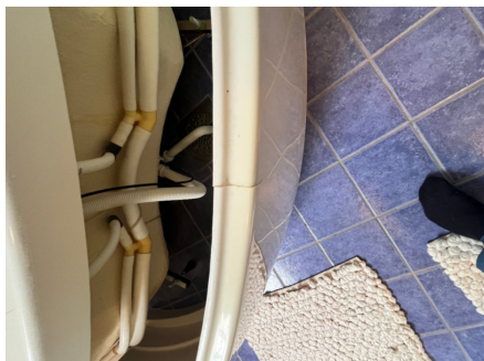
Sprekk i frontpanelet på badekaret.
