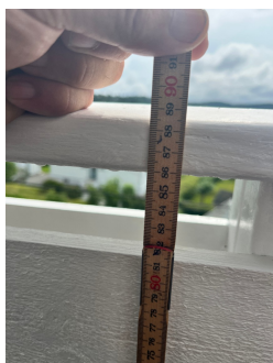
Høyde rekkverk balkong ca 88,5 cm.
