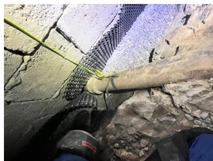
Soillrør som går ned under gulv i kjeller.
