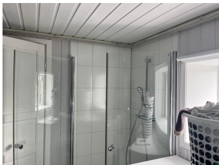
Vindu og dør i våtzone.
