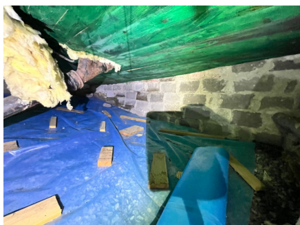
Soillrør og jernsluk fra toalettrom.
