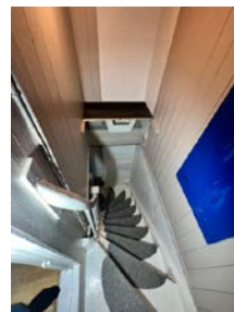
Mangler håndlist, ikke krav da boligen ble oppført.
