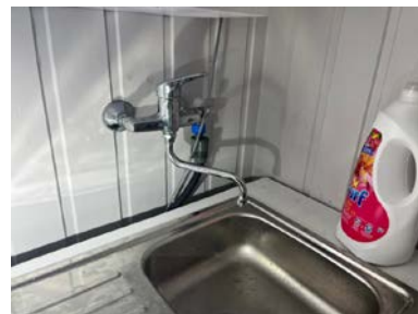
Panel på vegg i våtsone.
