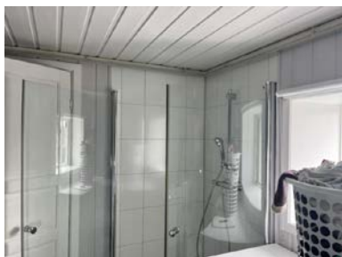
Vindu og dør i våtzone.
