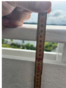
Høyde rekkverk balkong ca 88,5 cm.
