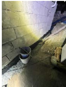
Synlig fuksikring i krypekjeller.
