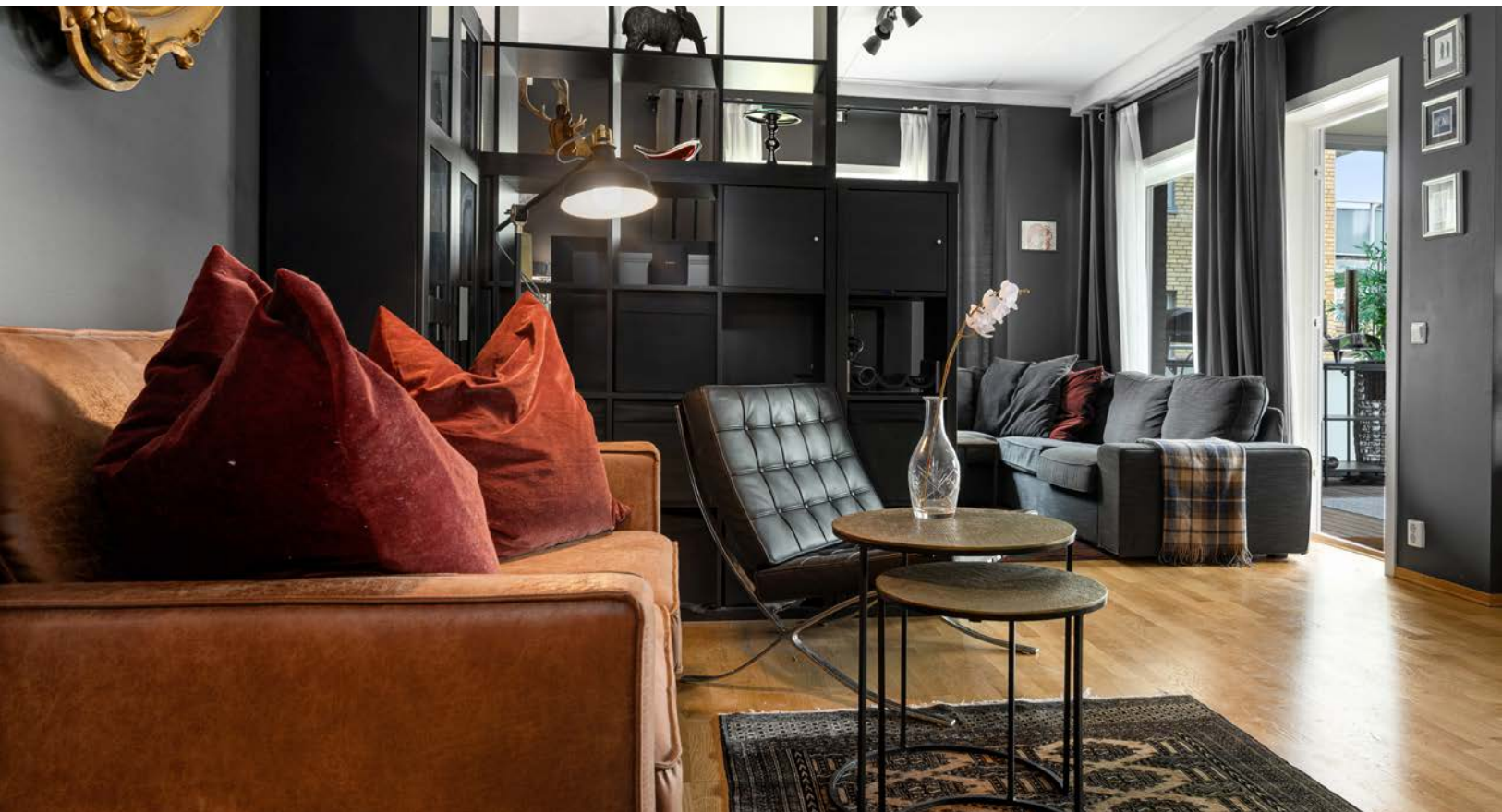
Det er vannbåren gulvvarme i alle rom.
