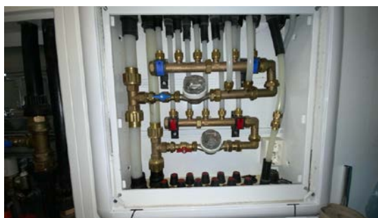
Besiktigelse av røropplegg.
