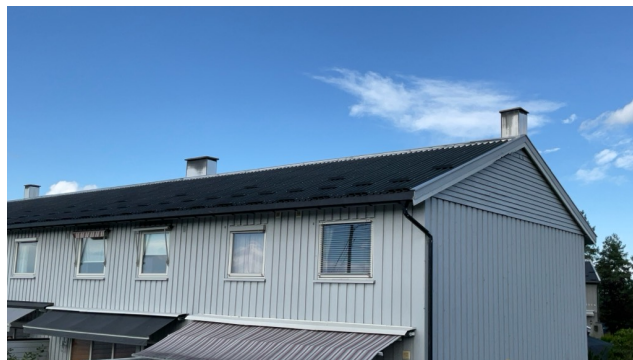
Tak av aluminiumsplater.
