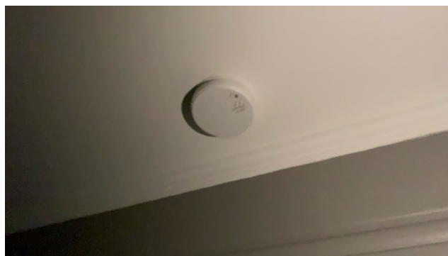
Røykvarsel 2 etasje.
