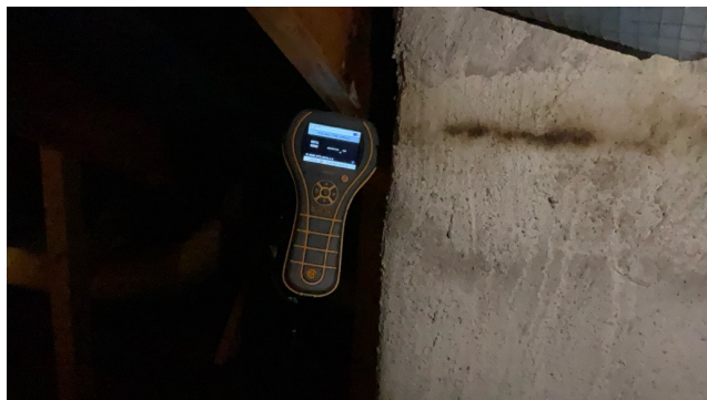
Ingen antydninger til fukt ved måling med pigger i fuktskjolde.
