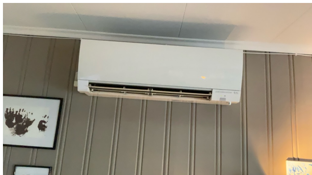
Varmepumpe.
