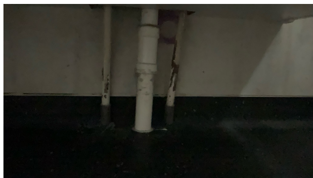
Vannledninger av kobber.
