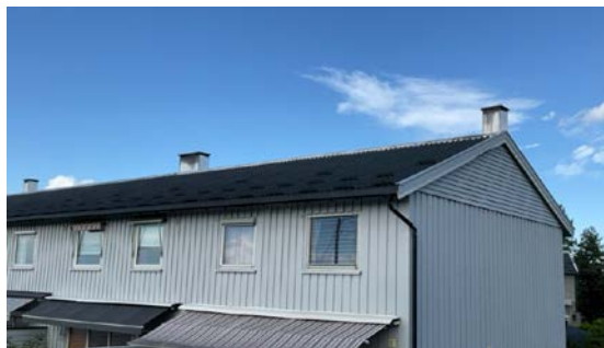
Tak av aluminiumsplater.
