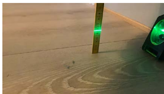
Det er målt 5,8cm på gulv ved vaskeromsdør.
