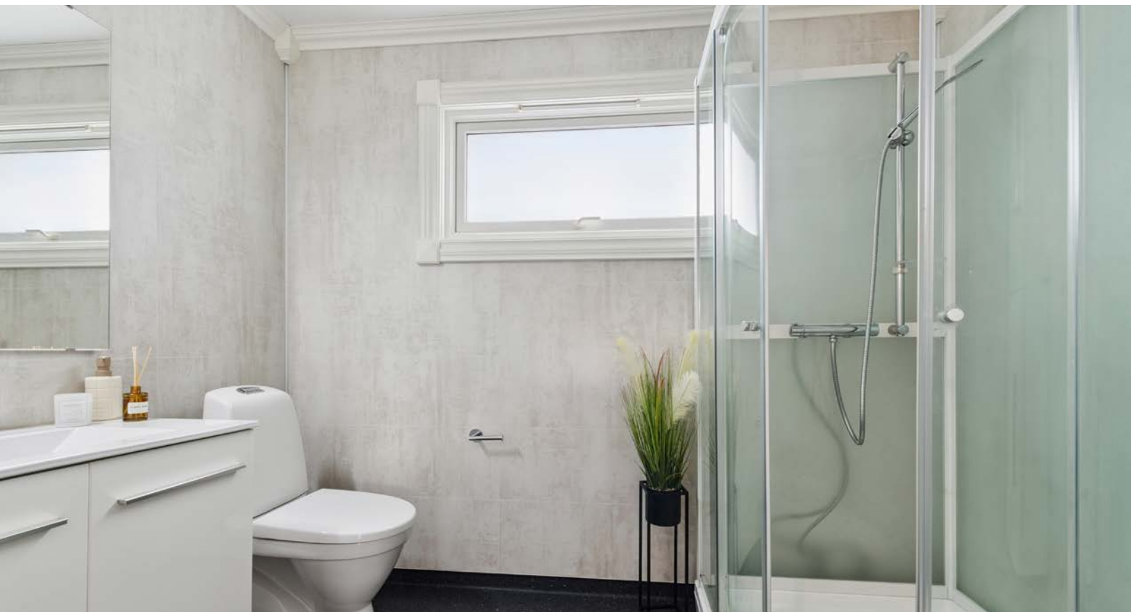
Badet ble pusset opp i 2016, og har vegger med baderomsplater og vinylbelegg m/varme på gulv.
