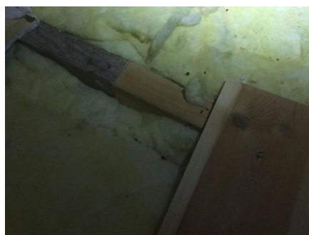
Synlig misfarging på undertak. Ved enkel fuktmåling registrerte jeg fukt. Årsak er lufting fra kloakk. Det er påvist spor etter mus, omfanget er ukjent.
