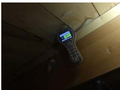
Synlig misfarging på undertak. Ved enkel fuktmåling registrerte jeg fukt. Årsak er lufting fra kloakk. Det er påvist spor etter mus, omfanget er ukjent.
