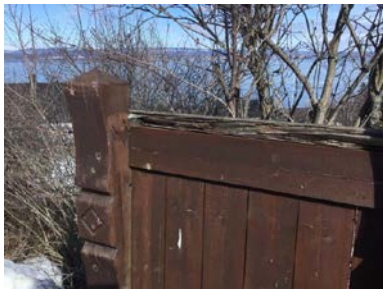
Råteskade på gjerde.
