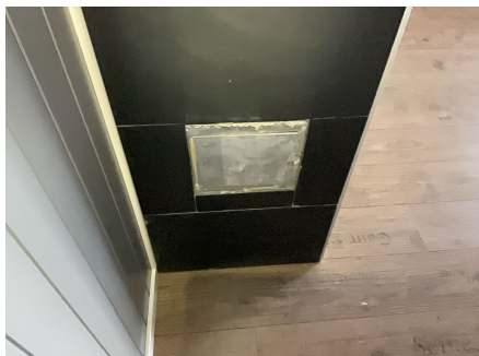
Sotluke plassert i kjeller.
