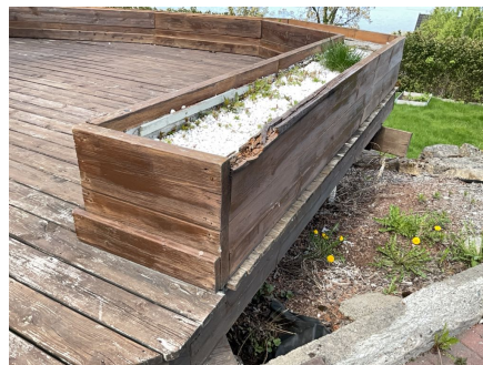
Råteskader på blomsterkasser.
