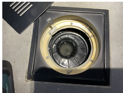
Skruer på klemring er strammet for hardt og er deformert. Klemring kan ha ujevnt trykk mot slukmansjett.
