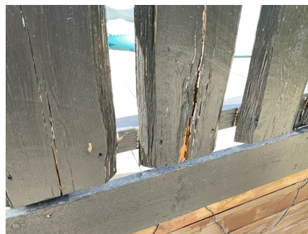
Råteskader på blomsterkasser.
