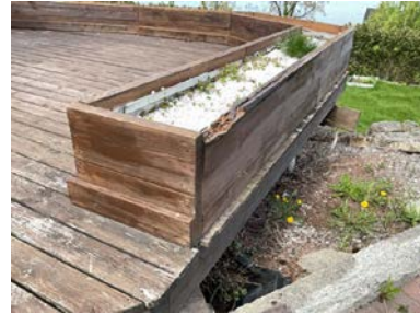
Råteskader på blomsterkasser.
