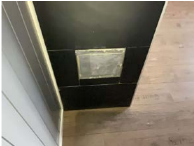
Sotluke plassert i kjeller.
