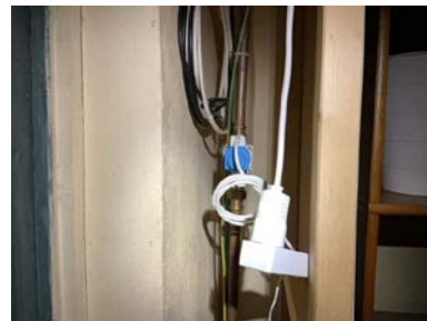
Fast installasjon skal ha fast tilkobling. Skjøteledning er benyttet på fast installasjon.
