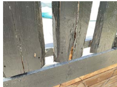
Råteskader på blomsterkasser.
