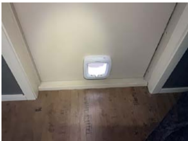
Katteluke montert i dør i kjeller.
