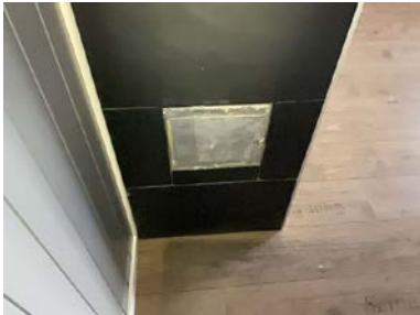
Sotluke plassert i kjeller.
