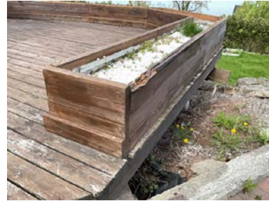
Råteskader på blomsterkasser.
