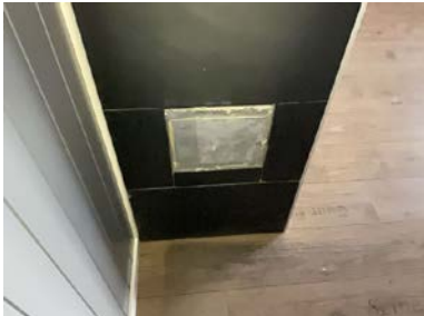
Sotluke plassert i kjeller.
