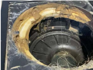
Hull i forhøyningsring i sluk.
