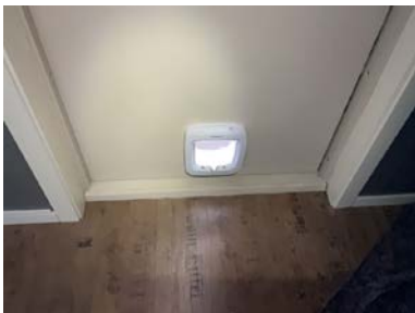
Katteluke montert i dør i kjeller.
